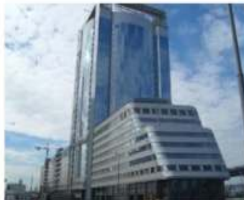
БЦ Северная башня
